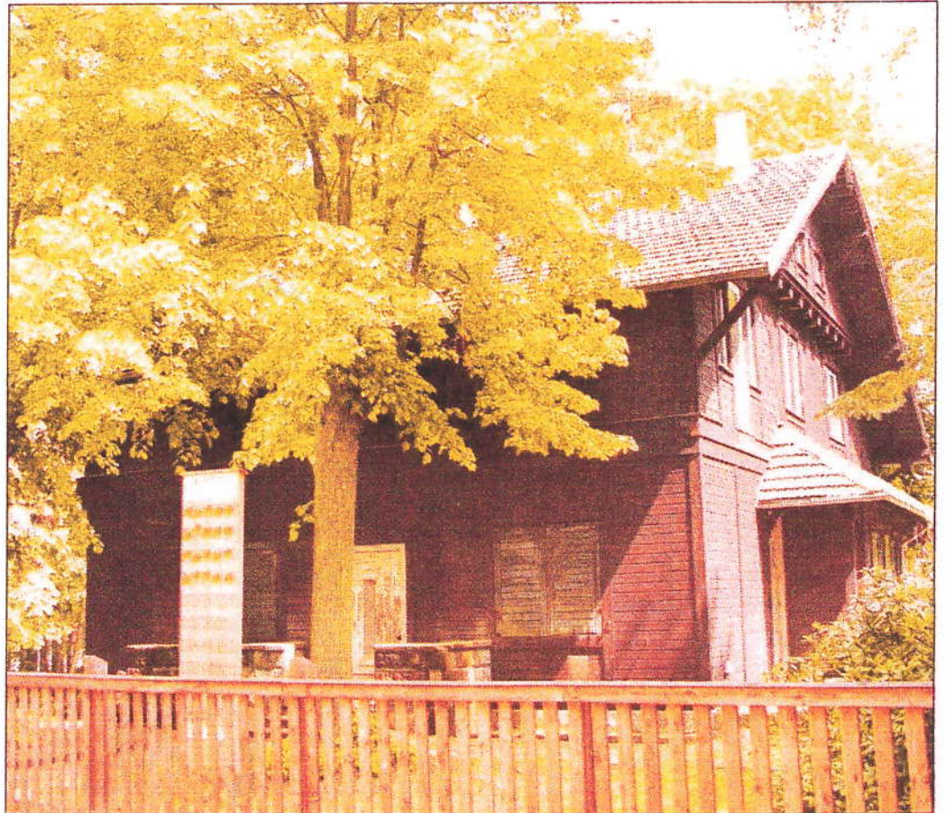
Erster Bauabschnitt noch in diesem Jahr: Das Scharwenka-Haus. Die Scharwenka-Stiftung hat zugesagt, nach Abschluss der Sanierung die laufenden Kosten zu tragen. Foto: MOZ/Bettina Winkler
