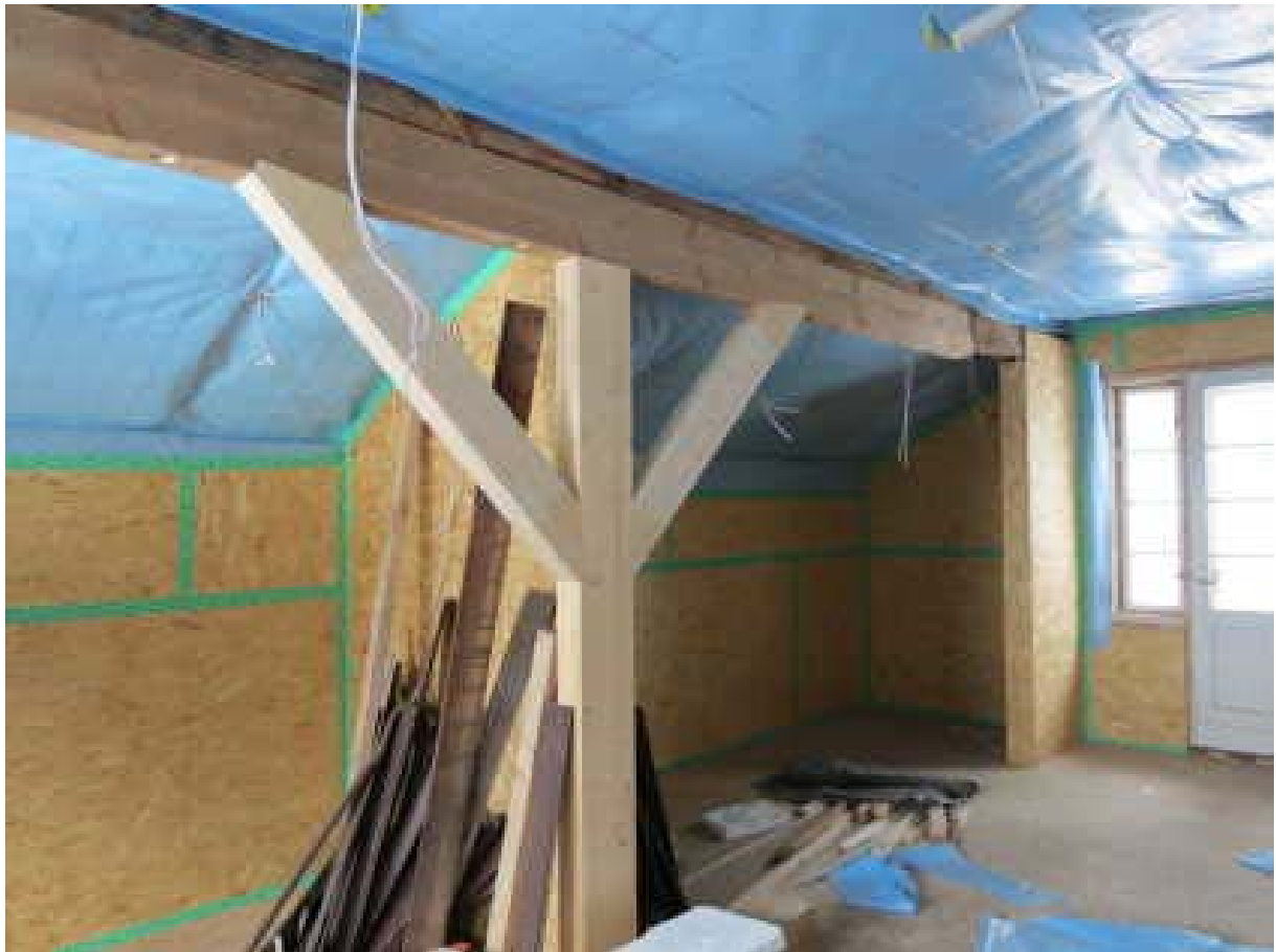
OG neue Balken
