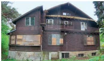
Nordfassade 2009 vor der Rekonstruktion
