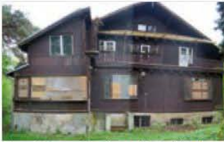
Scharwenkahaushaus, Nordfassade 2009 (oben) Südfassade 2013 (rechts). Archiv Scharwenka-Kulturforum
